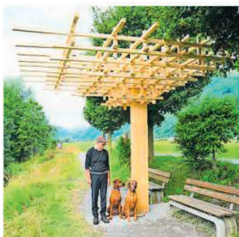
Fix installiert: Einbeindach von Sascha Klemm (2021). Gesteckt, ohne Nägel oder Leim.
